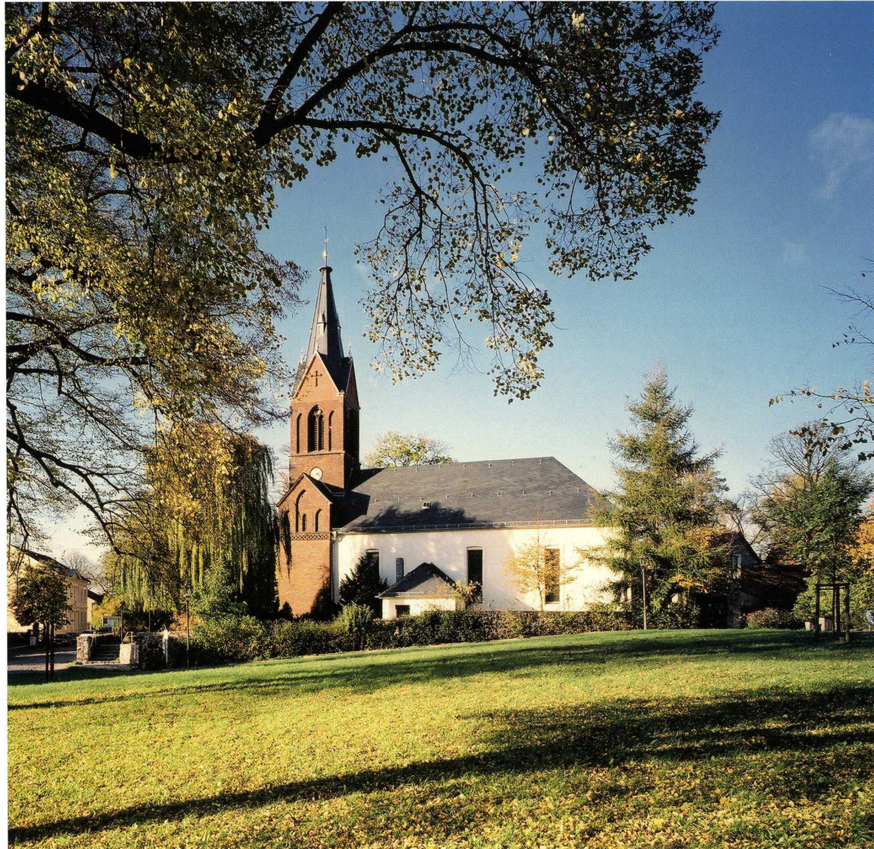
30 Dorfkirche in Mahlsdorf, Ansicht von Süden, 2001
